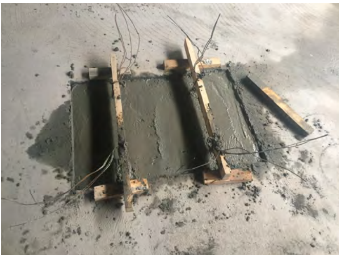
床下ピットへの入り口の閉鎖
