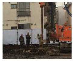
(3) 深度調整 【第3作業】 レベル器(左側三脚)を使い正確に杭打ち込み深度を決定する。
