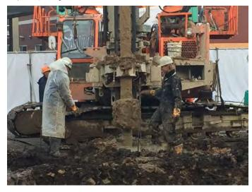
(2) 6 m杭の挿入作業 【第2作業】 左側写真より吊り下げ作業、挿入作業、作業完了。
