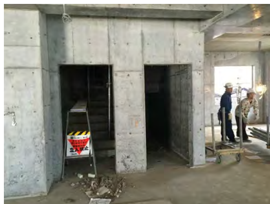
階段と機械室
