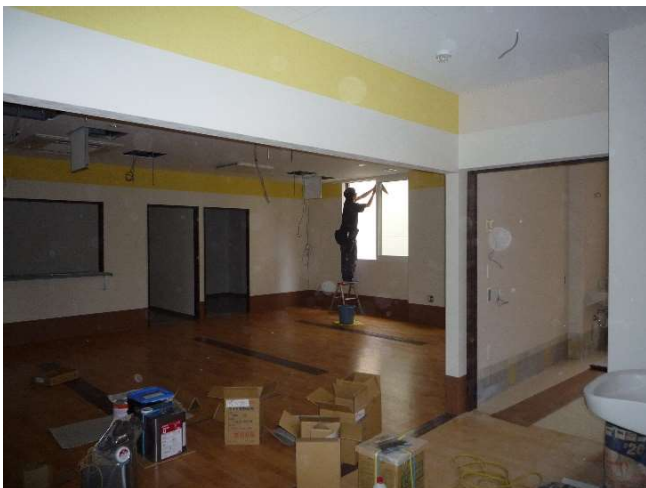
食堂の備品取り付け作業
